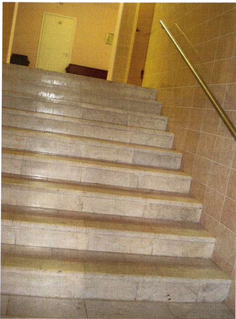
Лестница входа в помещение холла бассейна
