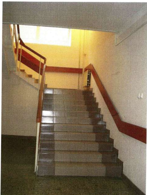
Лестница на этажи ЛФК
