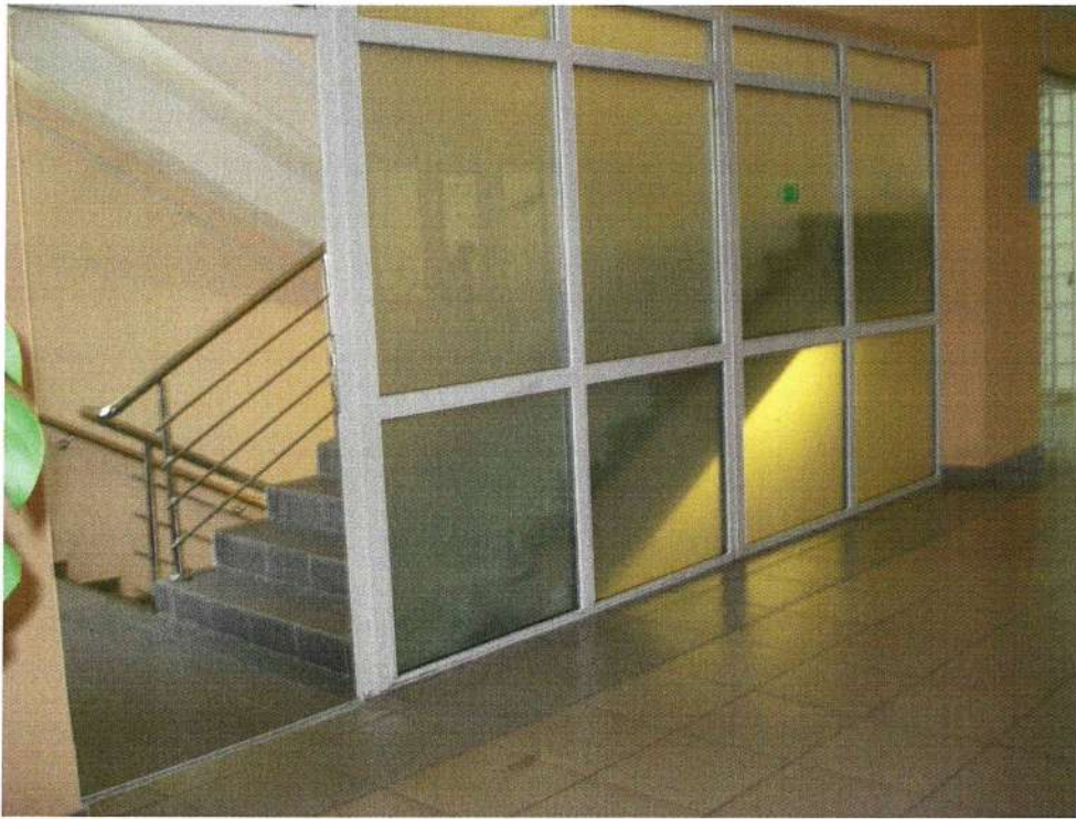
Выход с этажей на лестницу
