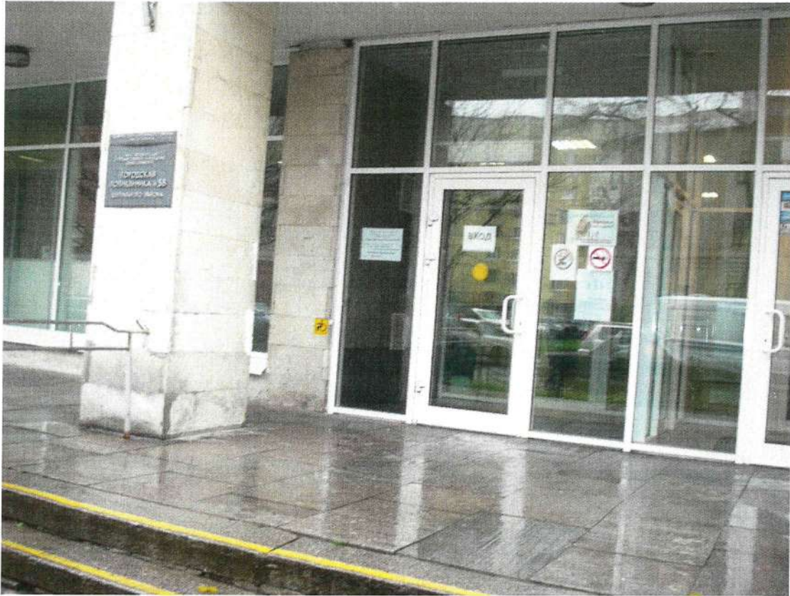
Главный вход в поликлинику
